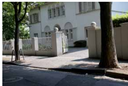
Abbildung 159 Zustand der Goethestraße im noch nicht sanierten Abschnitt
