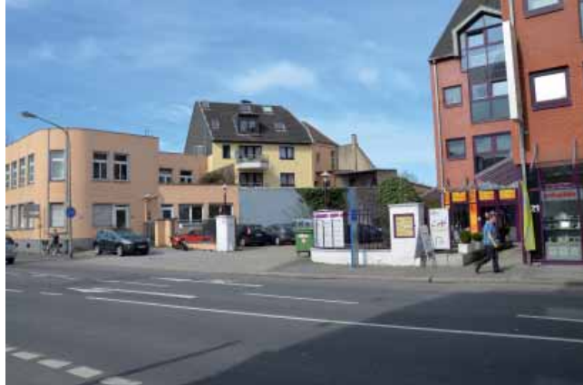
Abbildung 20 Baulücke an der Arnoldweilerstraße mit störendem Blick in den Blockinnenbereich
