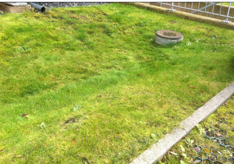
Mulde-Rigole zum Sammeln und Versickern von Regenwasser
