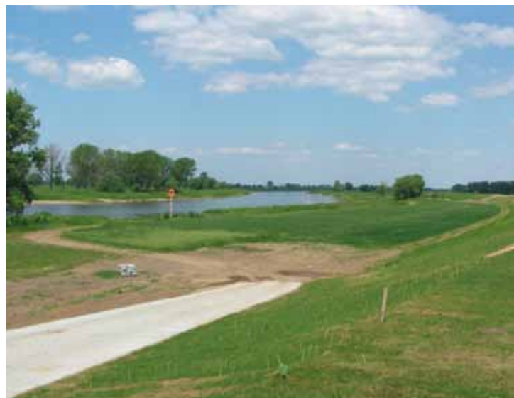
Hochwasserschutzdeich an der Elbe
