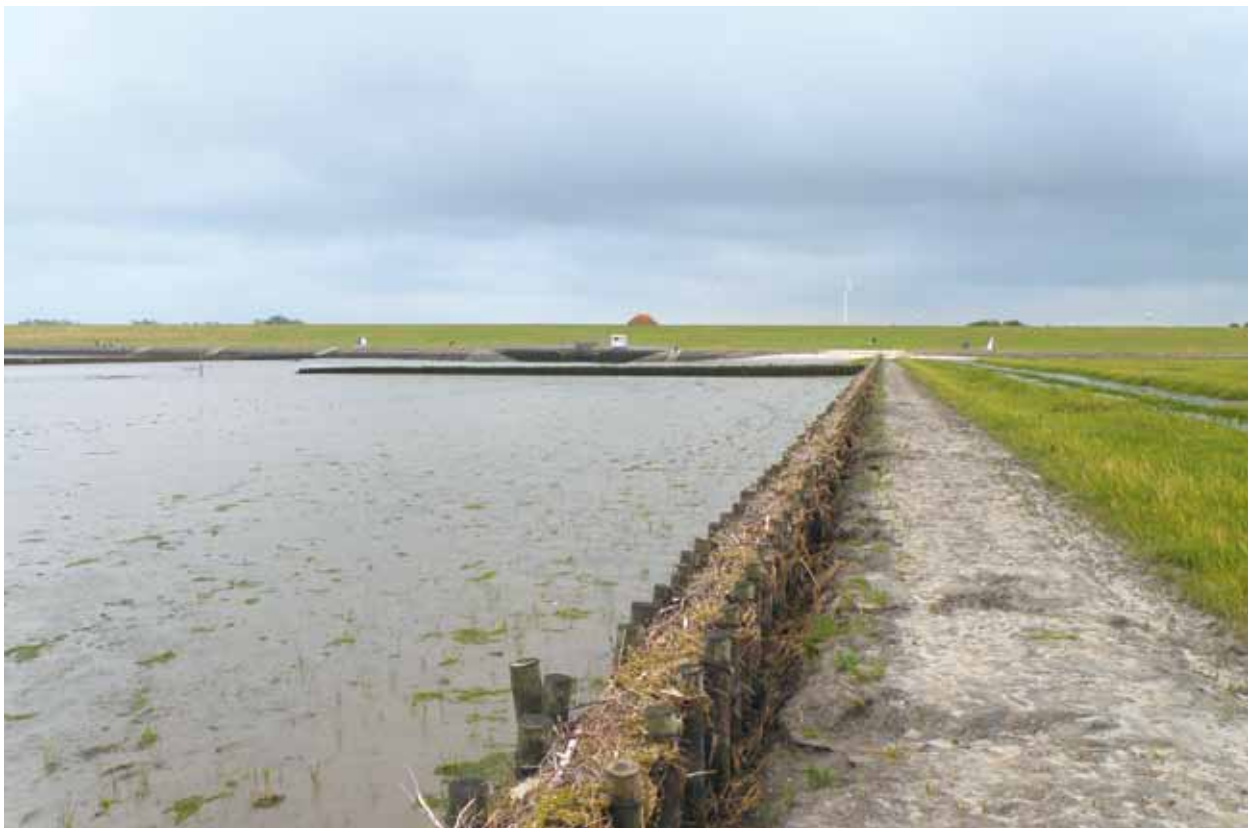
Küstenschutz mit Lahnungen und Hochwasserschutzdeich
