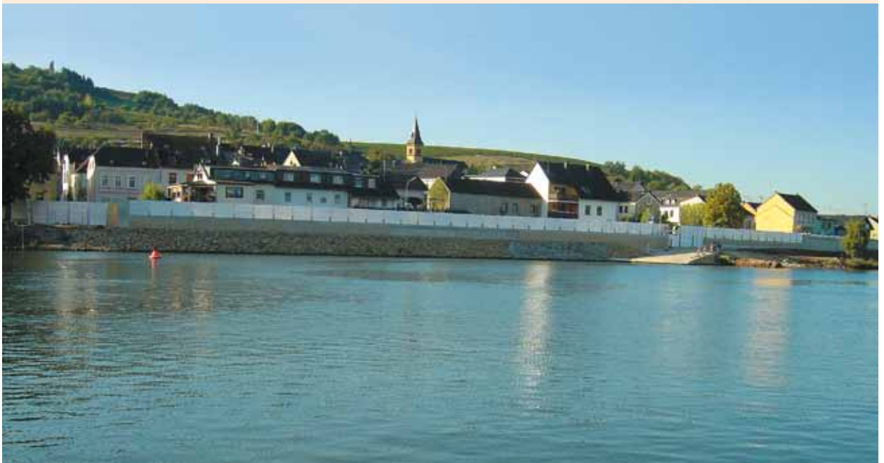
Hochwasserschutz in Oberbillig an der Mosel
