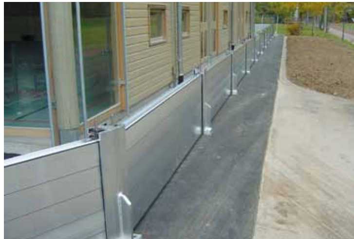
Umlaufender Hochwasserschutz mit teilmobilen Schutzelementen
