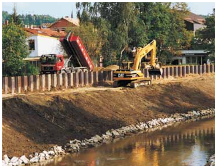
Hochwasserschutzwand mit Stahlspundwand im Bau
