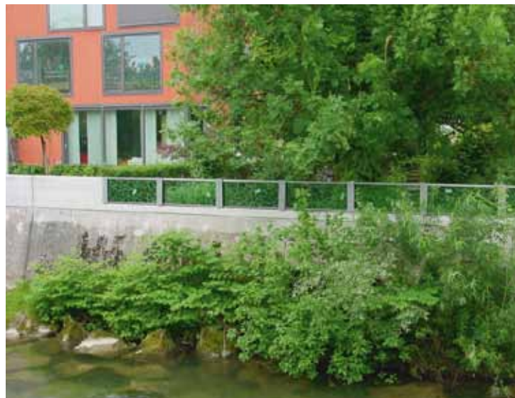
Hochwasserschutzwand mit Sicherheitsglas
