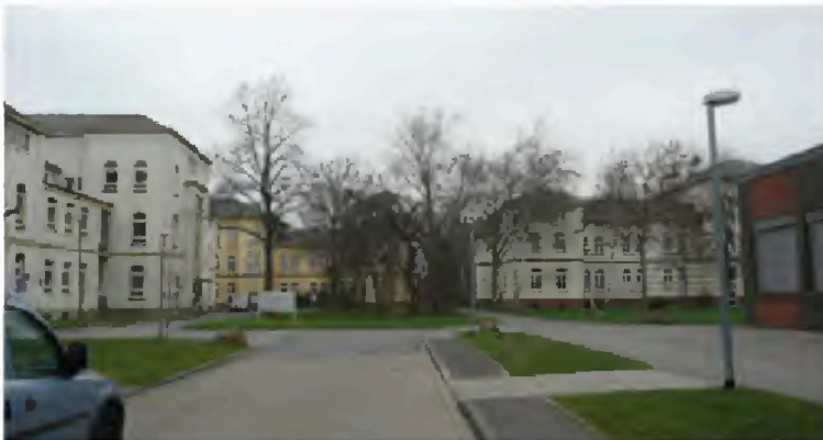
Abb. 18: LVR-Klinik-Gelände (Quelle: Stadt Düren)
